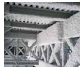
PROTEÇÃO DE ESTRUTURAS METÁLICAS
